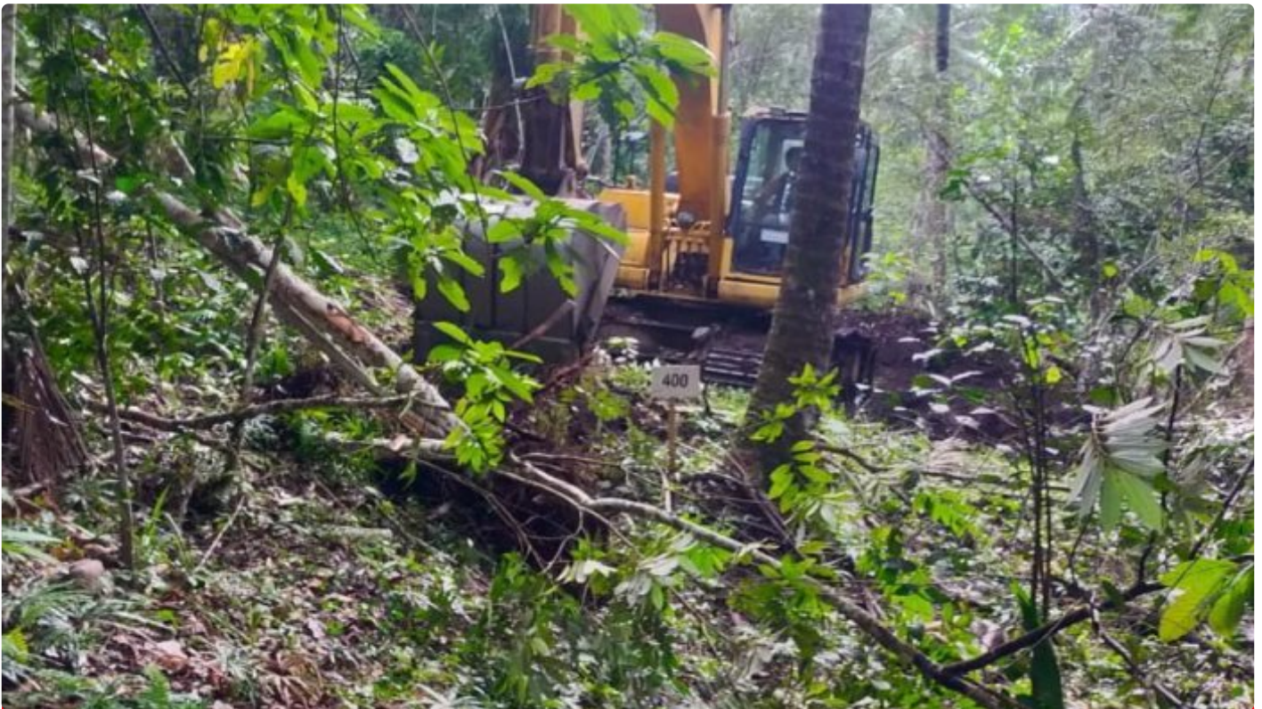
Pekerjaan akses Jalan TMMD Ke-116
