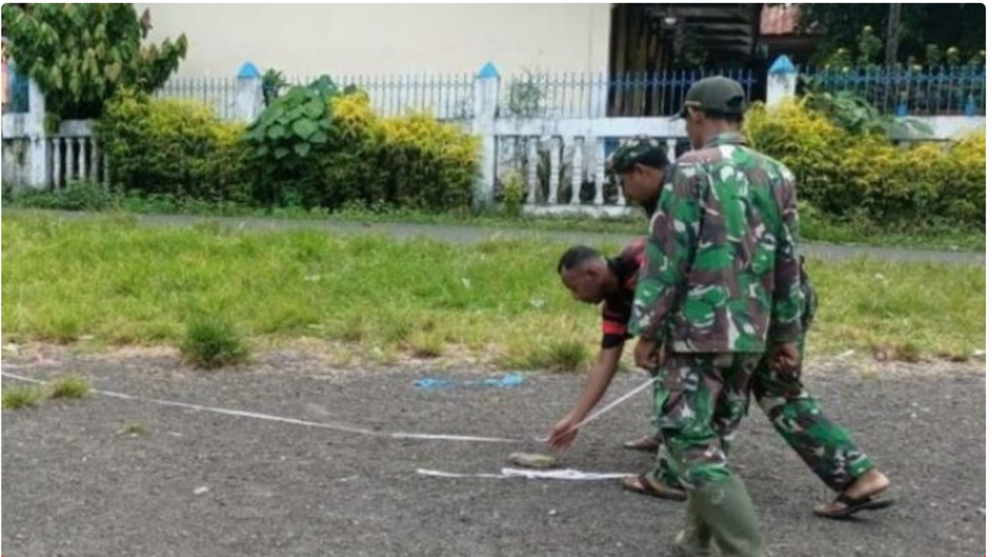
Satgas TMMD Lakukan Pengukuran Pembangunan Sarana Olahraga Jogging Track
