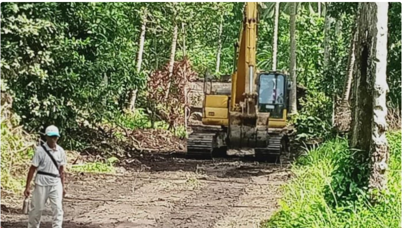
Pekerjaan Jalan Industri Pertanian pada TMMD Ke-116 di Kelurahan Tandurusa
