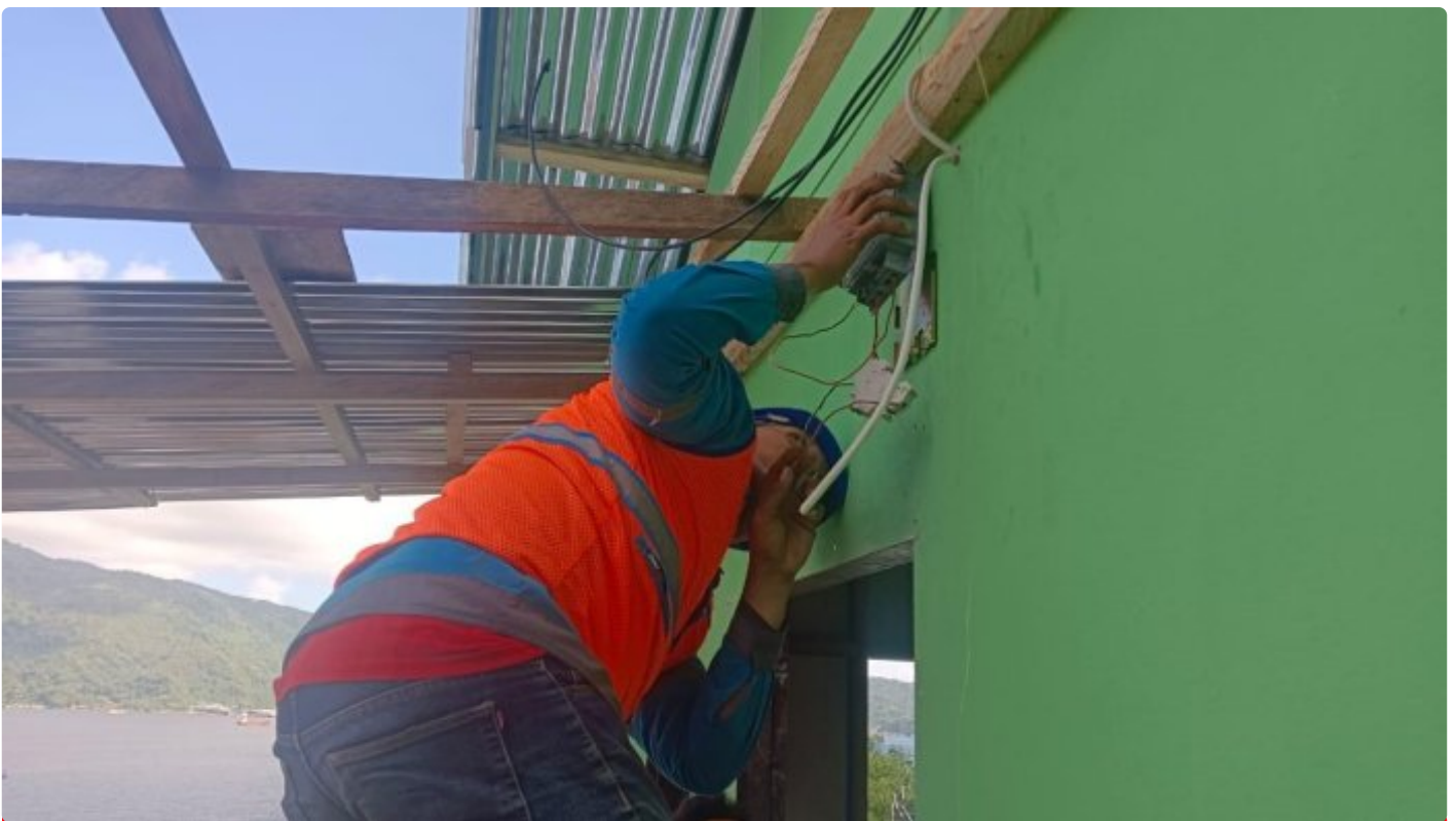
Pemasangan Instalasi RTLH oleh Satgas TMMD Ke-116 Kodim 1310 Bitung
