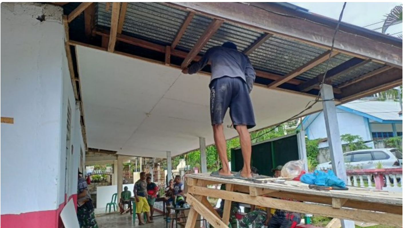
Satgas TMMD Renovasi Kantor Kelurahan Tandurusa
